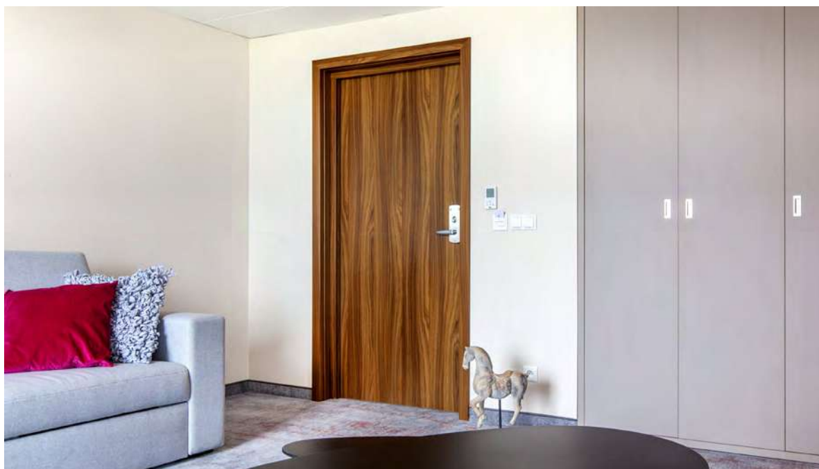
dveře EI60 PLUS, nastavitelná dřevěná zárubeň
