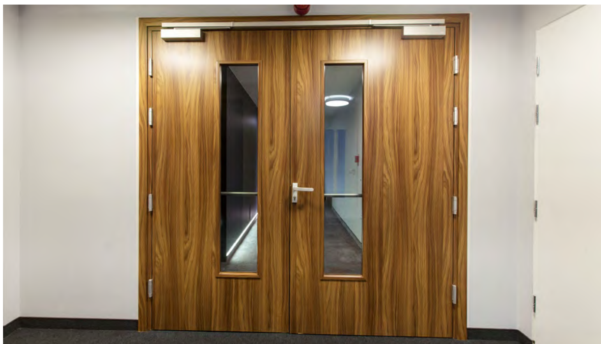
protipožární dveře FR EI30, pevná dřevěná zárubeň
