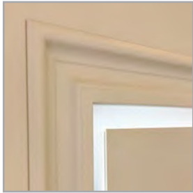
panel s dokončenou hranou nalepený na skle – verze V1SP
