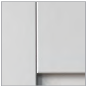
zkosení hran na spojení ráků
