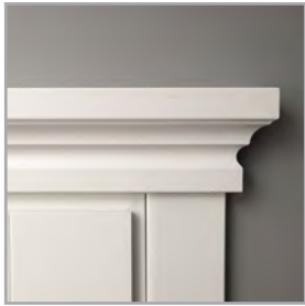
lišta i korunka jsou stříkané
