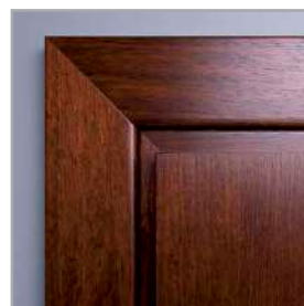
spojení obložkových lišt pod úhlem 45°
