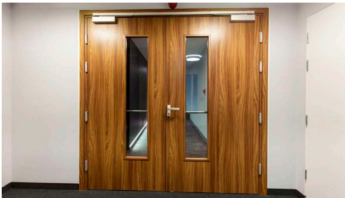
protipožární dveře FR EI30, pevná dřevěná zárubeň
