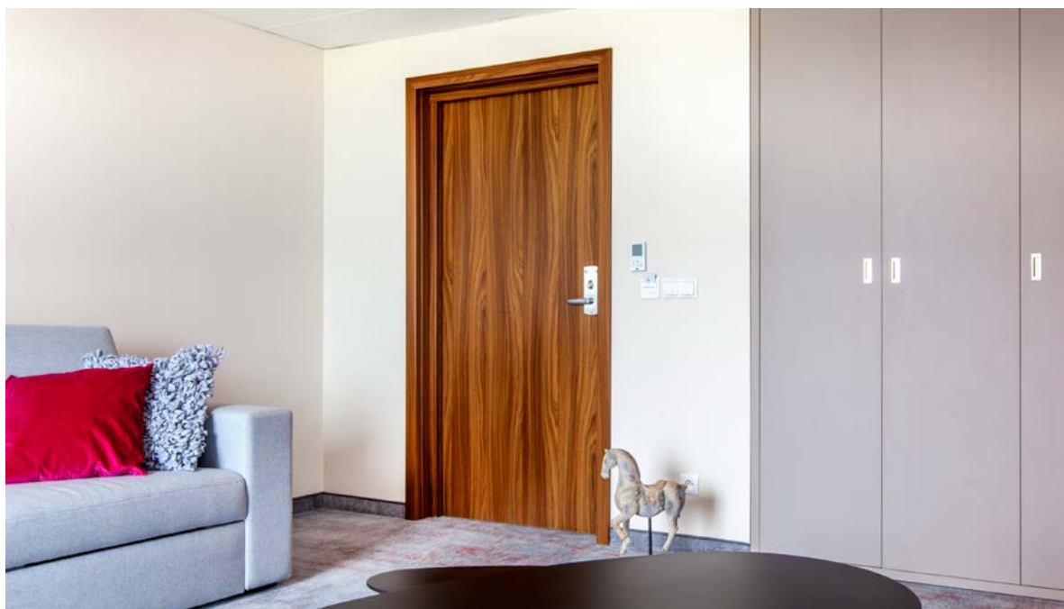
dveře EI60 PLUS, nastavitelná dřevěná zárubeň
