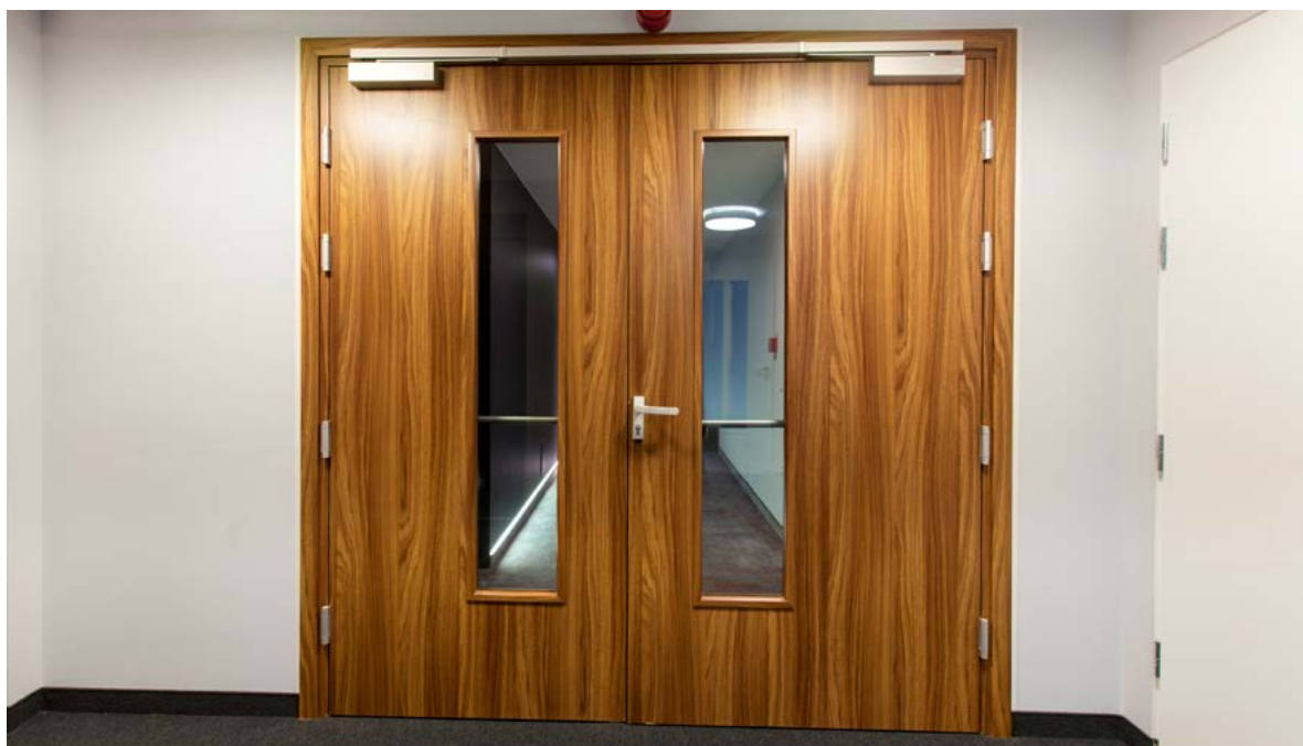
protipožární dveře FR EI30, pevná dřevěná zárubeň
