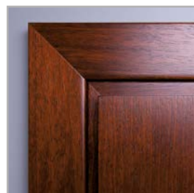
spojení obložkových lišt pod úhlem 45°
