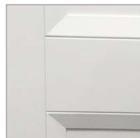
frézování na spoji rámu
