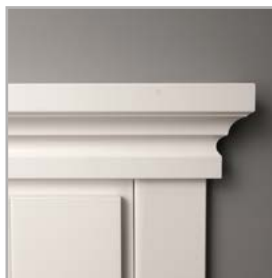
lišta i korunka jsou stříkané
